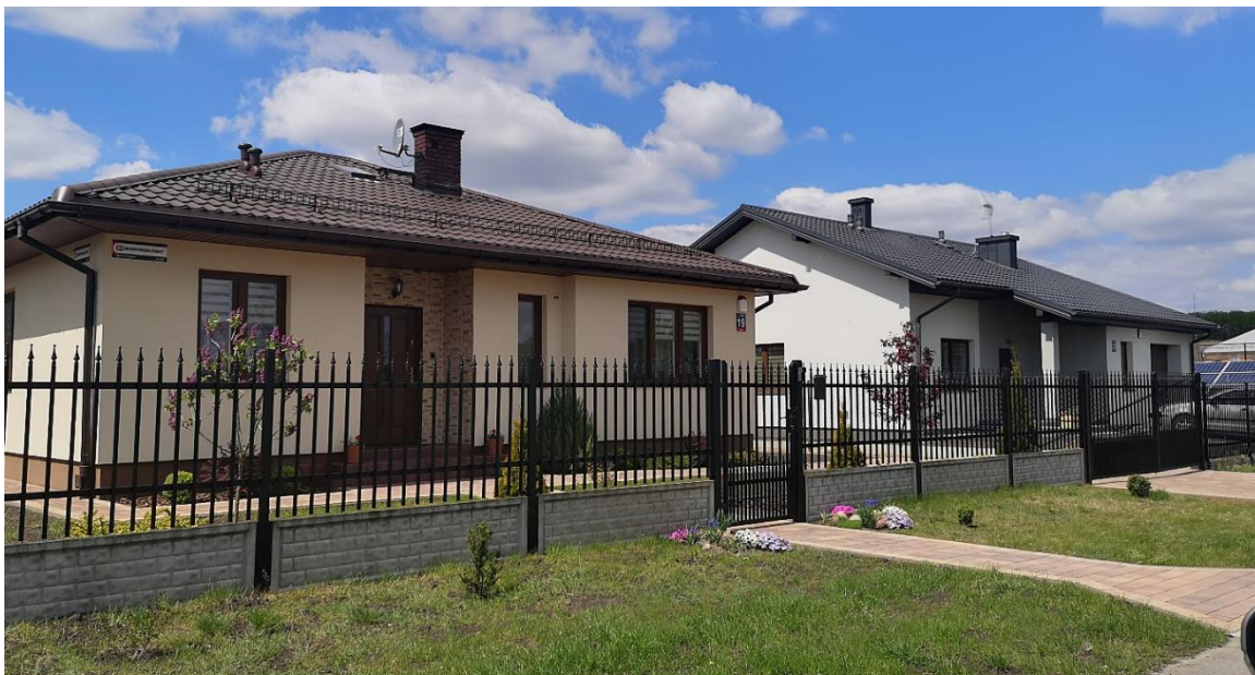
Zdjęcie 3. Budynek mieszkalny jednorodzinny., ulica Słoneczna 8, Janów. Źródło: Zdjęcie własne.
