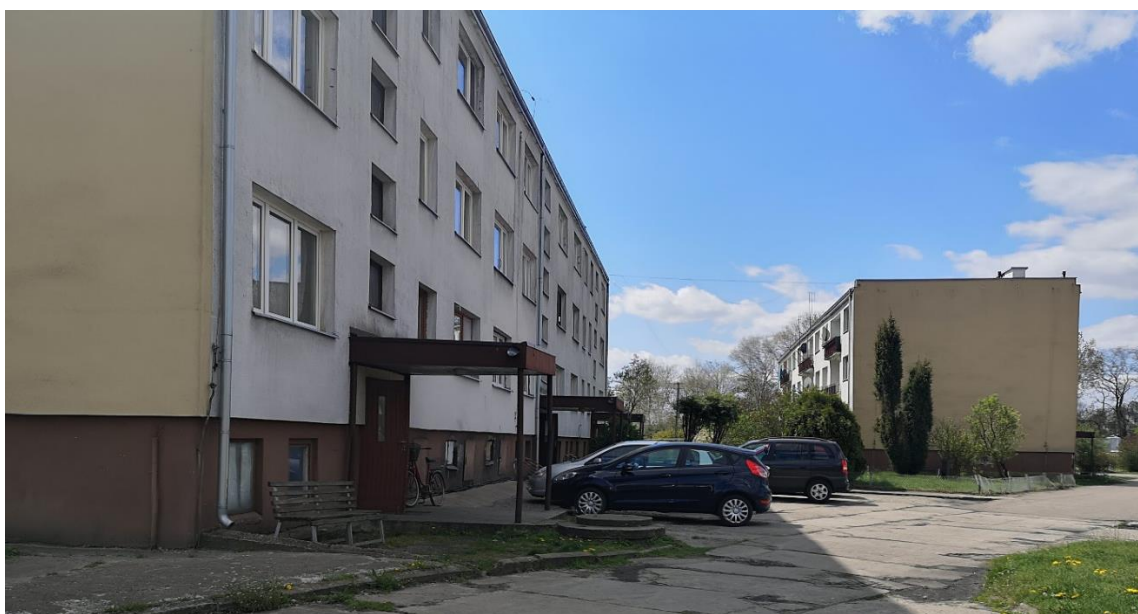
Zdjęcie 4. Budynki mieszkalne wielorodzinne, ulica Miła 1/2, Janów. Źródło: Zdjęcie własne.
